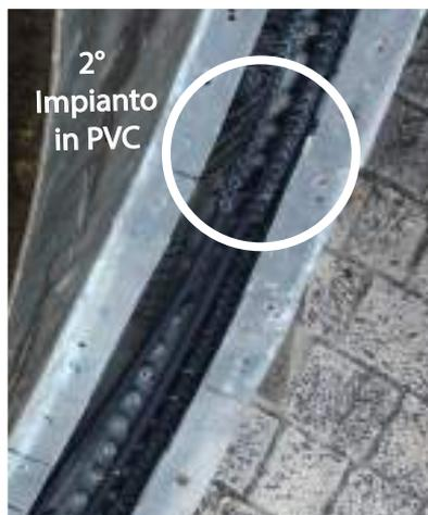
Nuovo impianto idrico in PVC esterno alla struttura, in sostituzione del vecchio impianto
